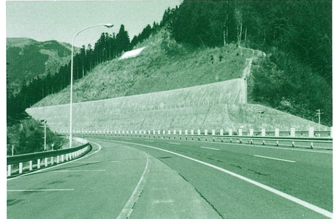
高速道路のもたれ擁壁、コンクリート吹付擁壁
