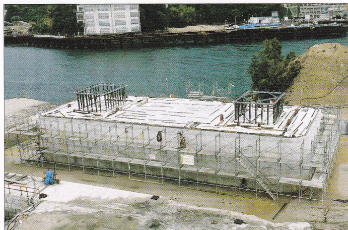
●Qマット使用例(橋脚基礎フーチング)
