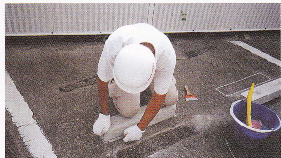
4. コンクリートブロックを すり合わせ するように圧着する。 はみ出したナルシルバー・ナルパークはコンクリートブロックにすり付ける。
