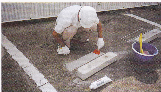
3. 据付個所にナルシルバー又はナルパークをコテ塗りする。 下地に不陸がある場合には、ブロックの接着面にもコテ塗りする。
