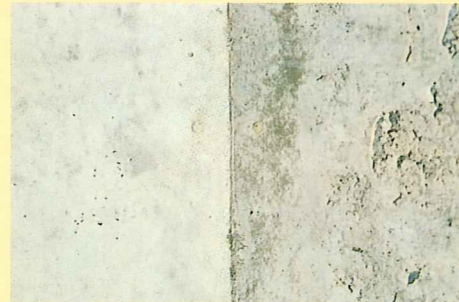
エアレックス使用 塗装型枠使用
