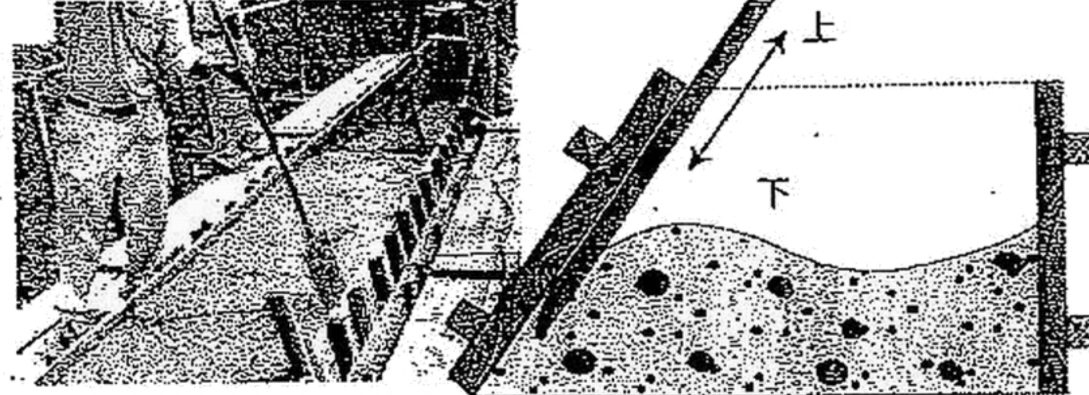
コンクリート打設時に型枠表面に沿って、ピカコンを上下に動かしながら差し込み、上下に動しながら引き上げる。
