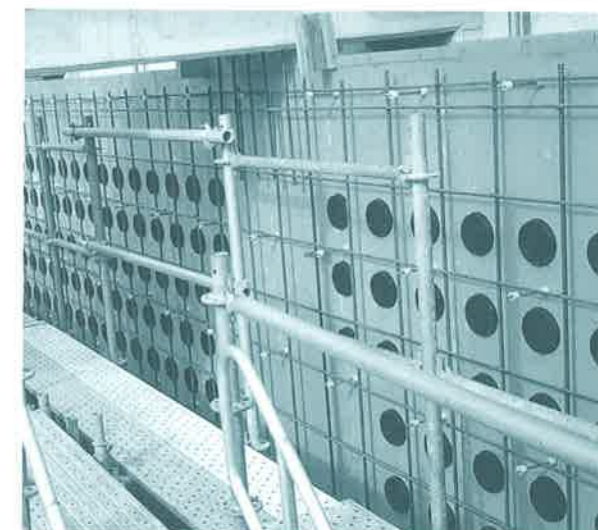
型枠にスリーブメイトX型を、釘1本で取りつけたところ。
