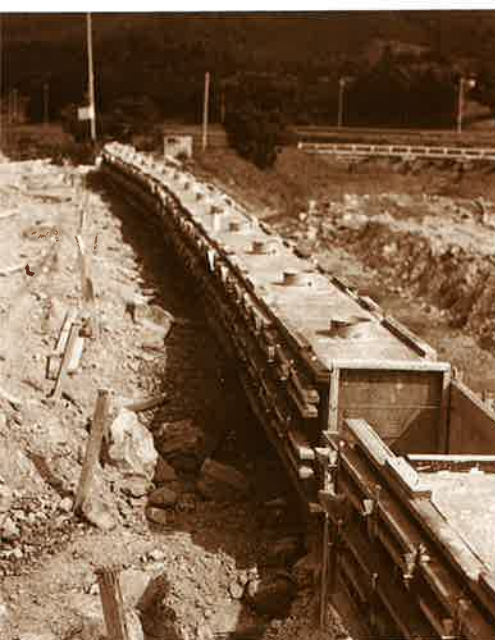
ブリージング水が引きコンクリートが安定すれば、ポイドは動きませんから、栈木とポイドホルダーを外します。この状態で鏡仕上げをします。
