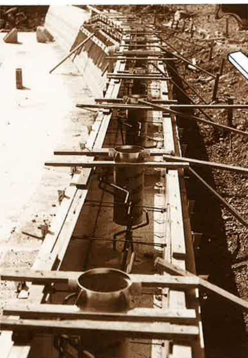
この状態で、コンクリートを打設します。
